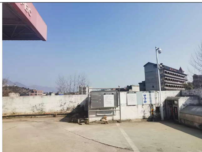
加油站卸油区
